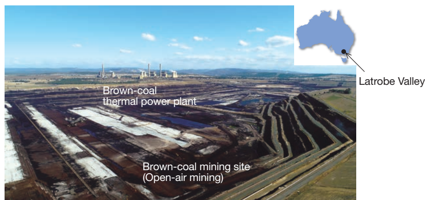
Fig. 2 Loy Yang Coalfield in Latrobe Valley, Australia
